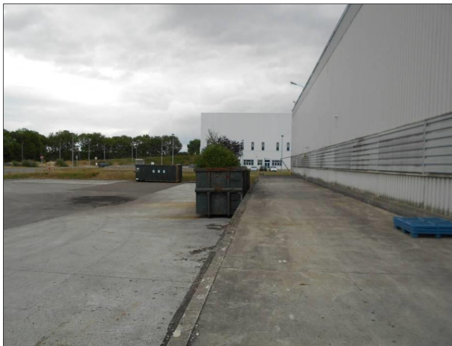
Figure 7: Prise de vue partie Ouest de l'installation en activité
