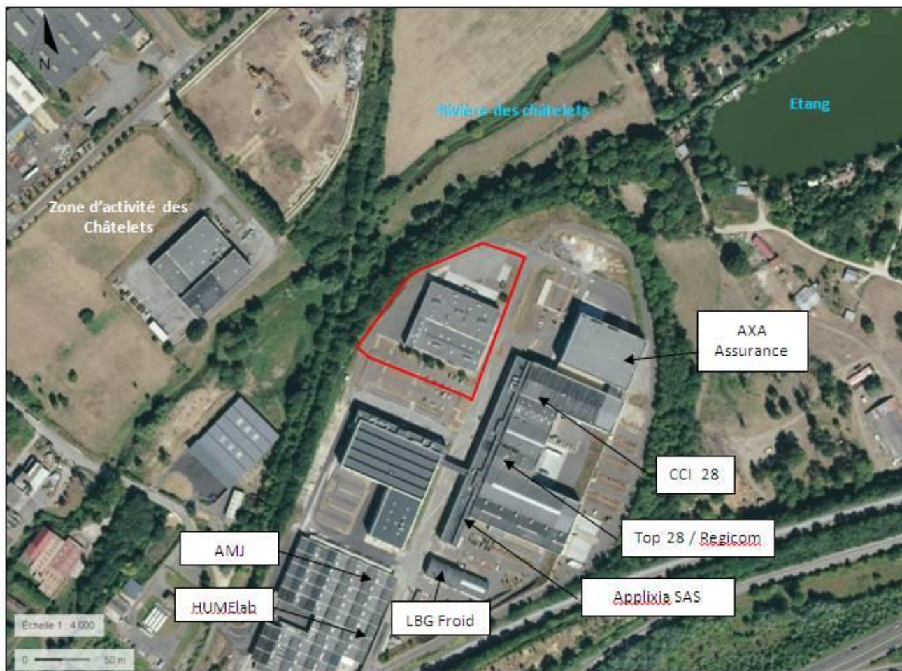
Figure 8: Vue aérienne du Parc d'Activités de la Radio
